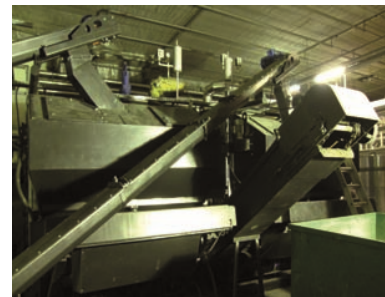
Fot. 1. Kociołownia w firmie VOLMARY Sp. z o.o.
